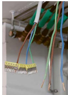
Bild 1: Fehlender Basisschutz
